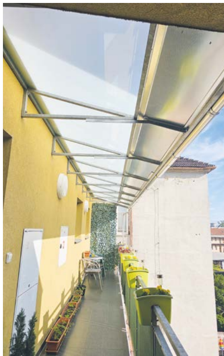
Nadstavená stříška nad pavlačemi domu Plotní 61 společně s novým okapem zajistí, že už nebude docházet k poškození dlažby
